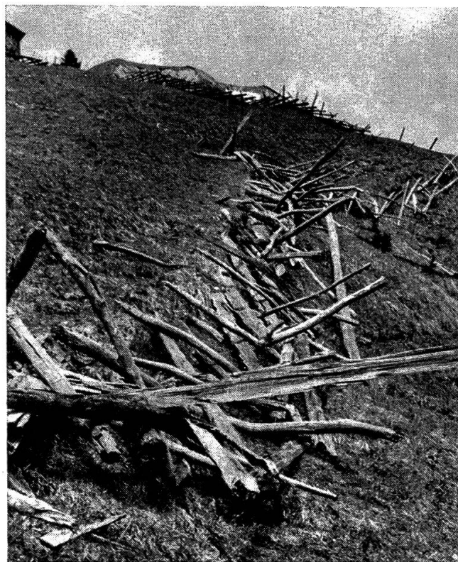
Durch Kriechschnee zusammengeschobener Weidzaun. Schachental. (Foto A. Huber.)
