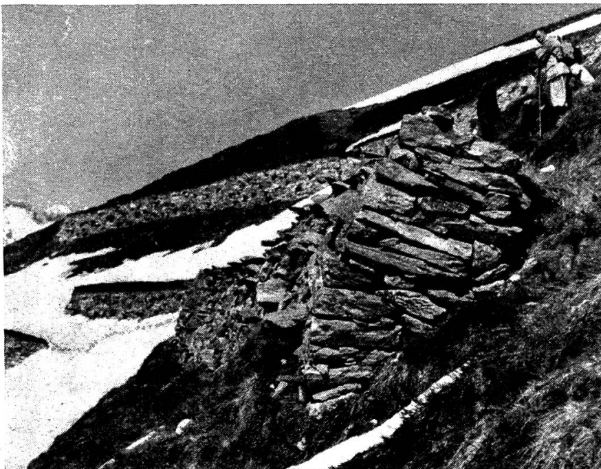
Freistehende Mauer im Kirchbergverbauungsgebiet (I. Etappe), die infolge Schneedrucks nach rückwärts fällt. Die Mauern im Hintergrund sind bereits zu Mauerterrassen umgebaut.
