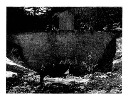
Le bassin était rempli à ras du barrage, l'eau passait par-dessus le couronnement; la circulation des ouvriers devenait dangereuse, c'est probablement la raison pour laquelle, précédemment, toute l'écluse était recouverte par un toit en pavillon, constituant un pont couvert.
