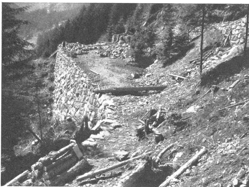
Waldwegbau Murg am Walensee. Große Kehre im Bau.
