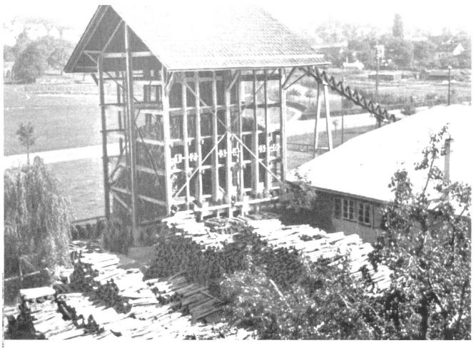
Bild 9. Die Gasholz-Trocknungsanlage der Schenkung Dapples, in Zürich, 1941. Silobau mit sechs Trocknungssilos.
