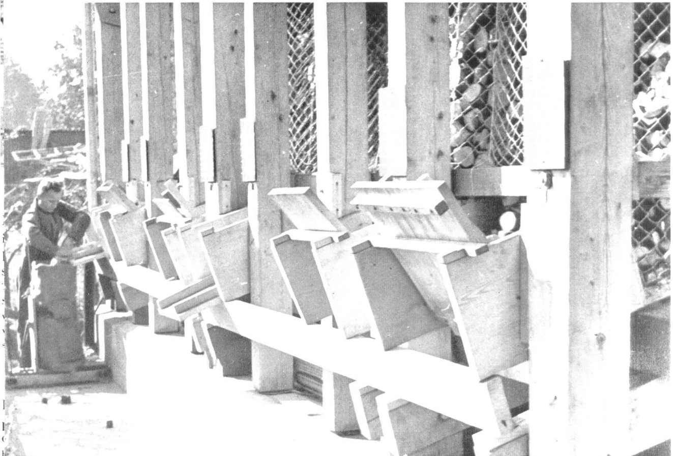
Bild 10. Siloausläufe mit Klappverschlüssen.
