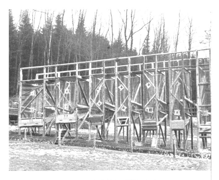
Bild 1 und 2. Versuchs-Trocknungsanlage für Hackholz auf Waldegg bei Zürich, 1937.
