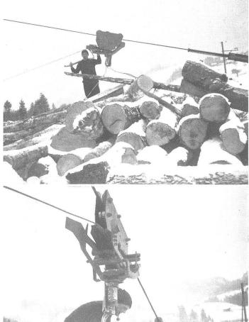
Bild 10. Durch Oeffnen des Schliessbügels wird an der Talstation die Last vom Laufwagen gelöst.
