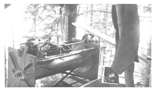
Bild 6. Der Laufwagen auf der Bergfahrt kurz vor der Kuppelung mit dem Stellwagen (oben).
