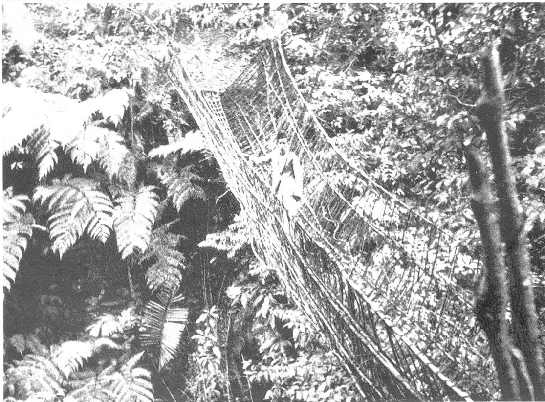
Bild 3 (oben). Königsbäume als Urwaldrelikte; im Hintergrund der Soeroengan. Bild 4 (unten). Hängebrücke aus Rotanseilen über den Asahan.
