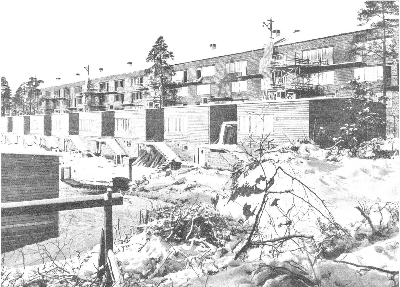
Bild 10. Reihenhaushaus in Holz für Angestellte der schwedischen Konsumgenossenschaften bei Stockholm. Da die Gesamtanlage Eigentum des gleichen Besitzers ist, sind keine Brandmauern vorgeschrieben, dagegen Aussenputz. Oben: Während des Baues.
