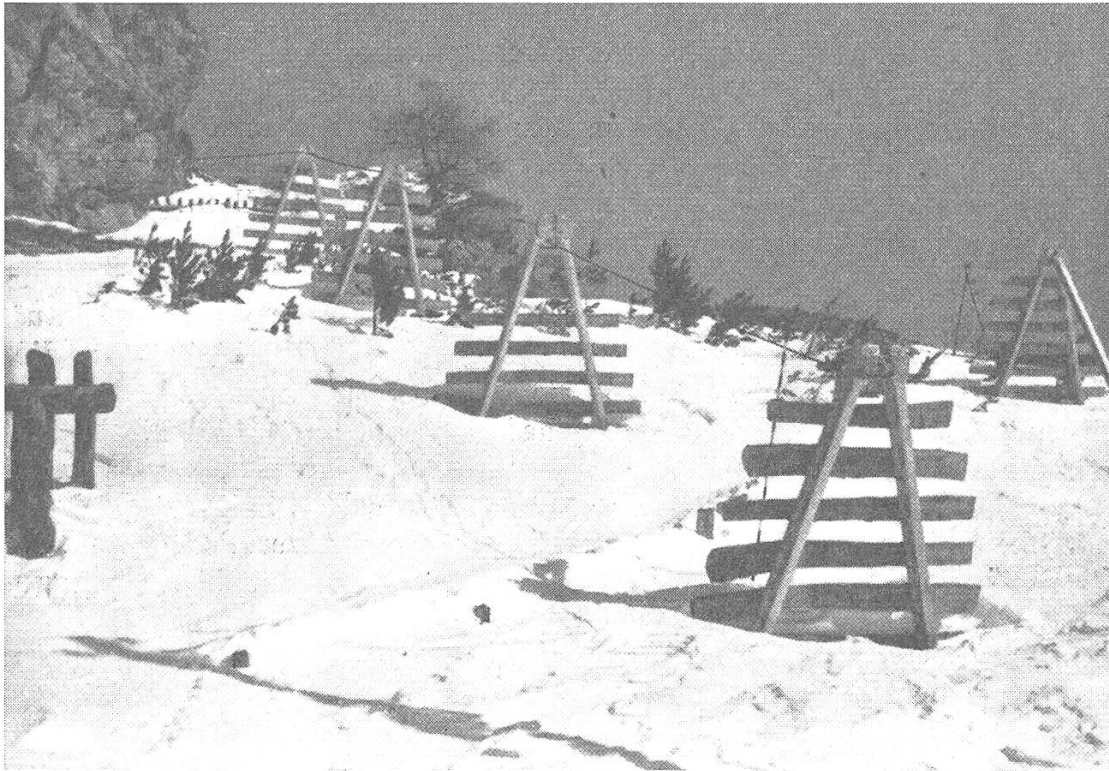
Bild 6. Versuchsverbauung Alp Grüm. Links Hängeelemente, rechts Stützelement.
