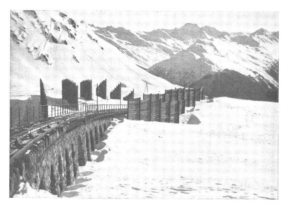
Bild 9. Gwächtenwände der Parsennbahn.
