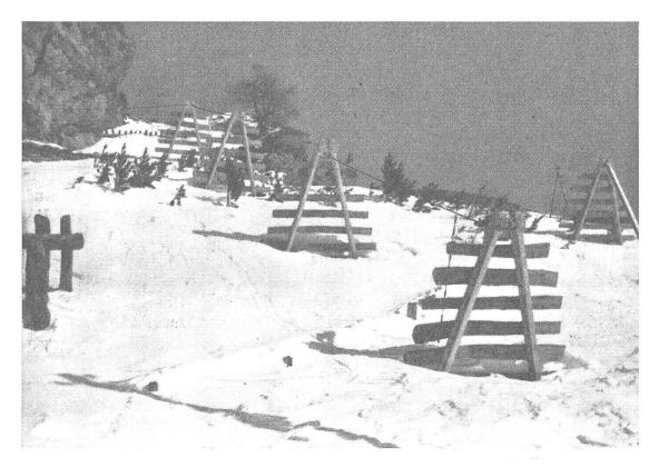
Bild 6. Versuchsverbauung Alp Grüm. Links Hängeelemente, rechts Stützelement.
