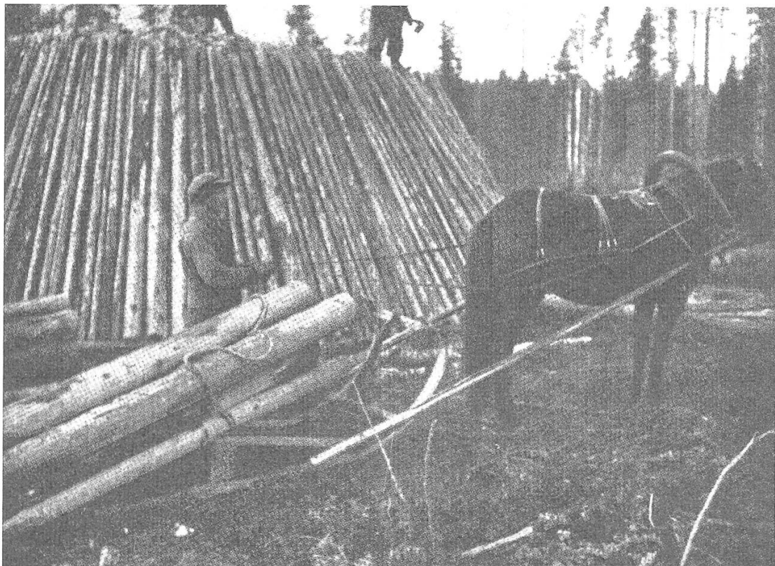
Bild 2. Aufstellung eines Meilers aus 3 m langem Durchforstungsholz.
