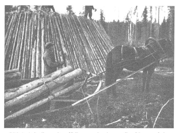
Bild 2. Aufstellung eines Meilers aus 3 m langem Durchforstungsholz.
