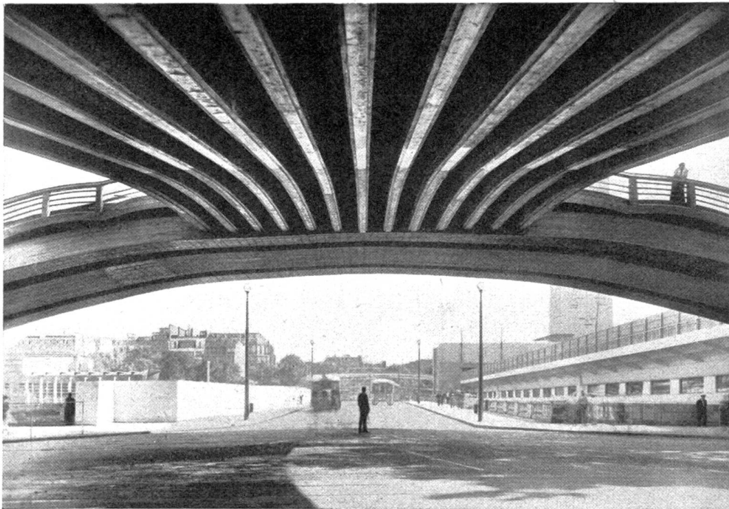
Der Holzbogen von 65 m Spannweite und die gewölbte Passerelle von 12 m Breite.
