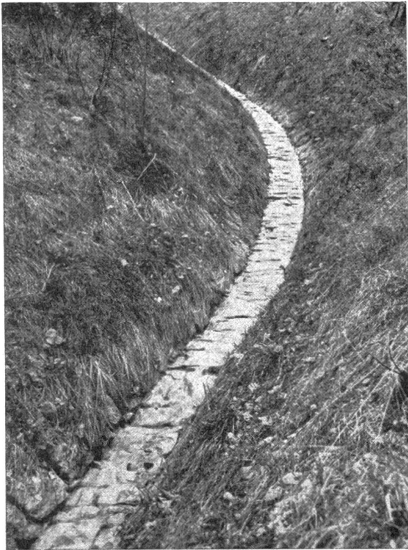
Bild 4. Aufnahme Kaiser. Sohlensicherung der Hauptgräben mit Sandsteinen.
