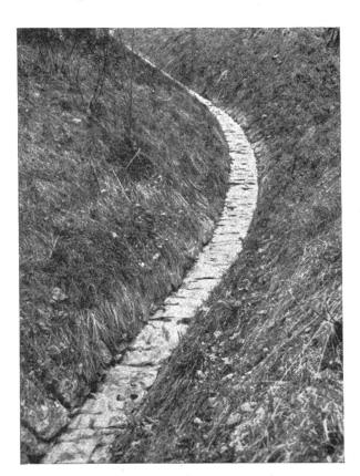
Bild 4. Aufnahme Kaiser. Sohlensicherung der Hauptgräben mit Sandsteinen.
