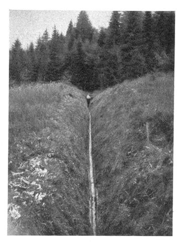
Bild 3. Aufnahme Kaiser. Sohlensicherung in den Hauptgräben mit Latten.
