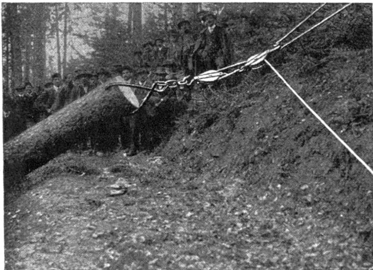
Ohne den „RACO“ wäre es nicht möglich gewesen, diesen wertvollen Stamm von 4 m<sup>3</sup> auf einer Steigung von 60 % an den Fahrweg zu fördern. Er hätte am Standort **zersägt** werden müssen und dadurch eine bedeutende **Entwertung** erfahren. Mit der Holzschielefeinrichtung „RACO“ fördern Sie Nutzholz auch dort, wo dies sonst nicht möglich ist.
