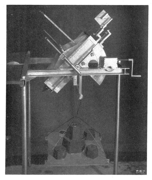
Abb. 6. Grosser Scherapparat im Schneeforschungs-Laboratorium Weissfluhjoch.
