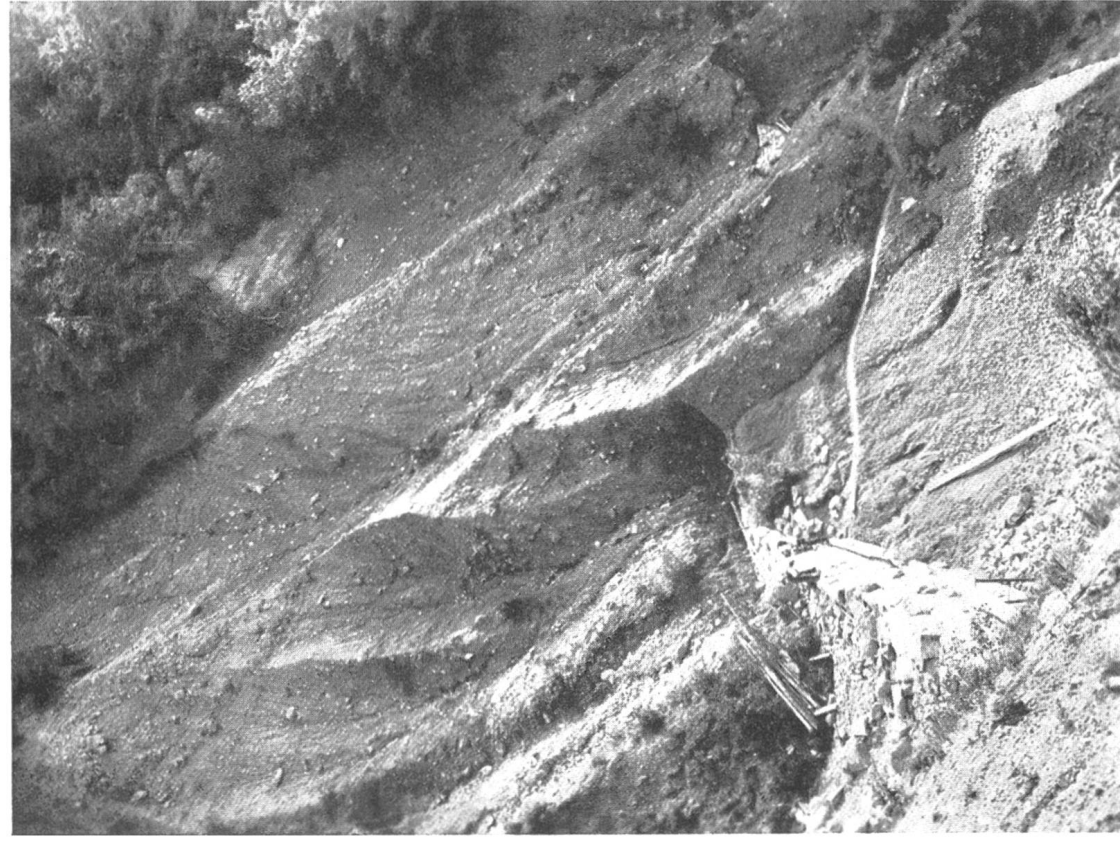
Aufforstung und Verbau der „Buochser-Rübi“, Sektion 2, Korporation Buochs. Bild 6. Vollständig verrückte Seitenlehne im Gebiet der „Buochser-Rüebi“ bei Inangriffnahme der Verbauung im Hauptgerinne im Jahre 1934.
