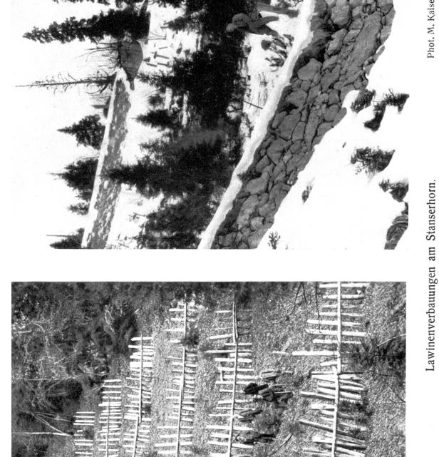
Bild 4. Das alte System der Verbauung mit Pfahlreihen.
