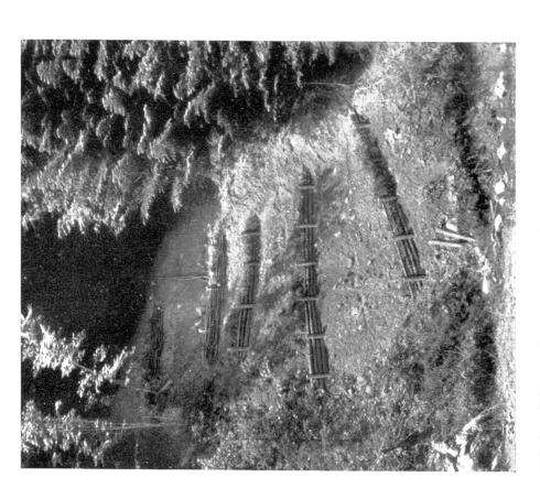
Bild 2. Kleiner Rutsch, oben abgeböscht, verbaut, noch unbesät und unbepflanzt.
