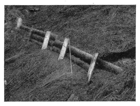
Bild 6. Verbauungsdetail. (Vorn Meterstab. Spaltpfähle 1,5 m lang. Die kahle Rutschfläche ist, zur Humusbildung, mit herausgesäubertem Unkraut bestreut.)
