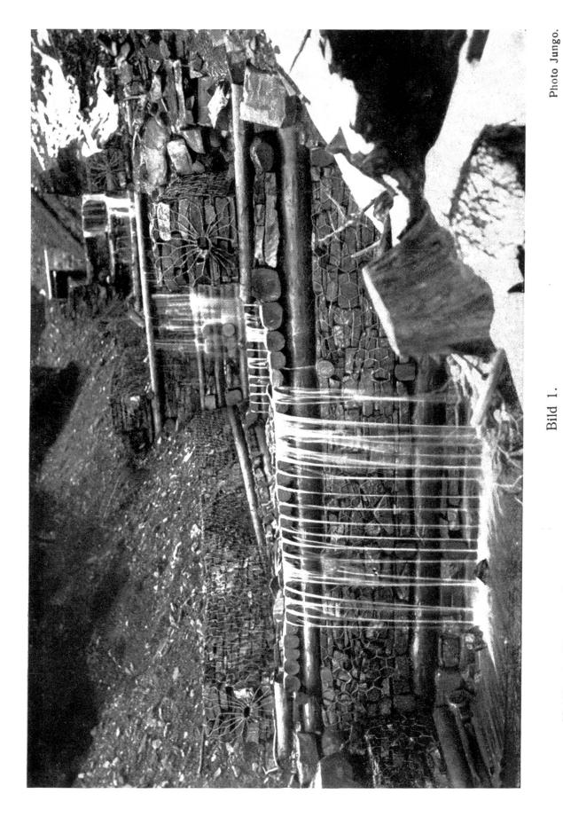
Höllibach. Kleinere Sperren und Uferfußsicherungen aus vierkantig ausgefüllten Drahtgittersäcken.
