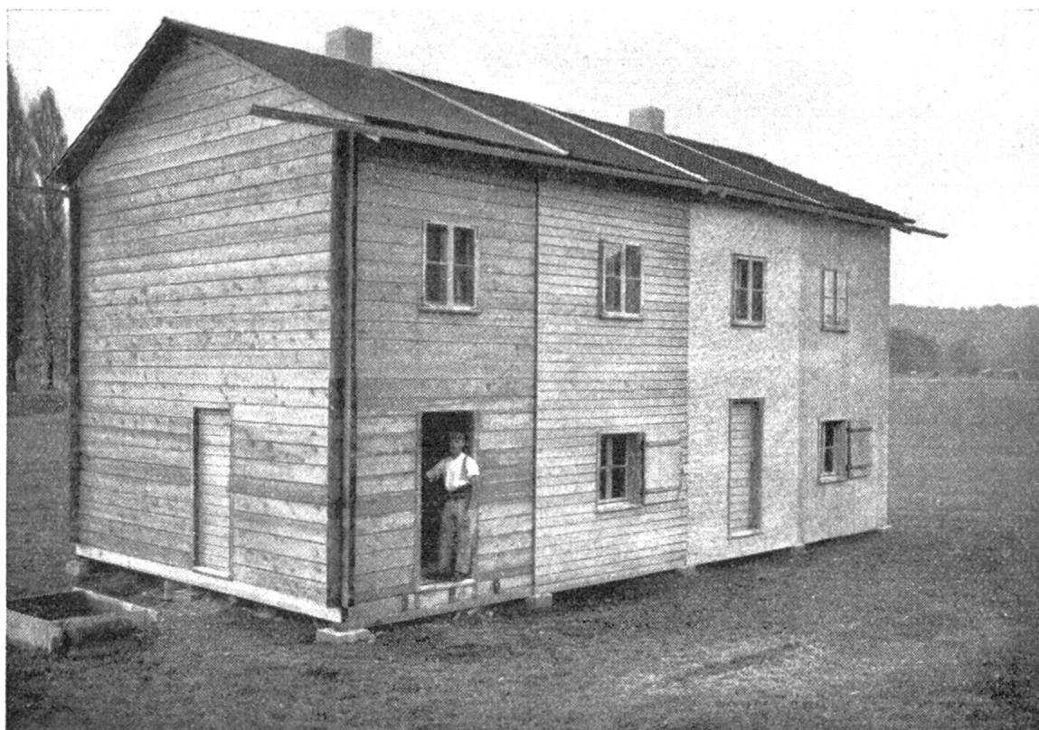
Holzhaus für Brandversuche auf der Zürcher Allmend.
