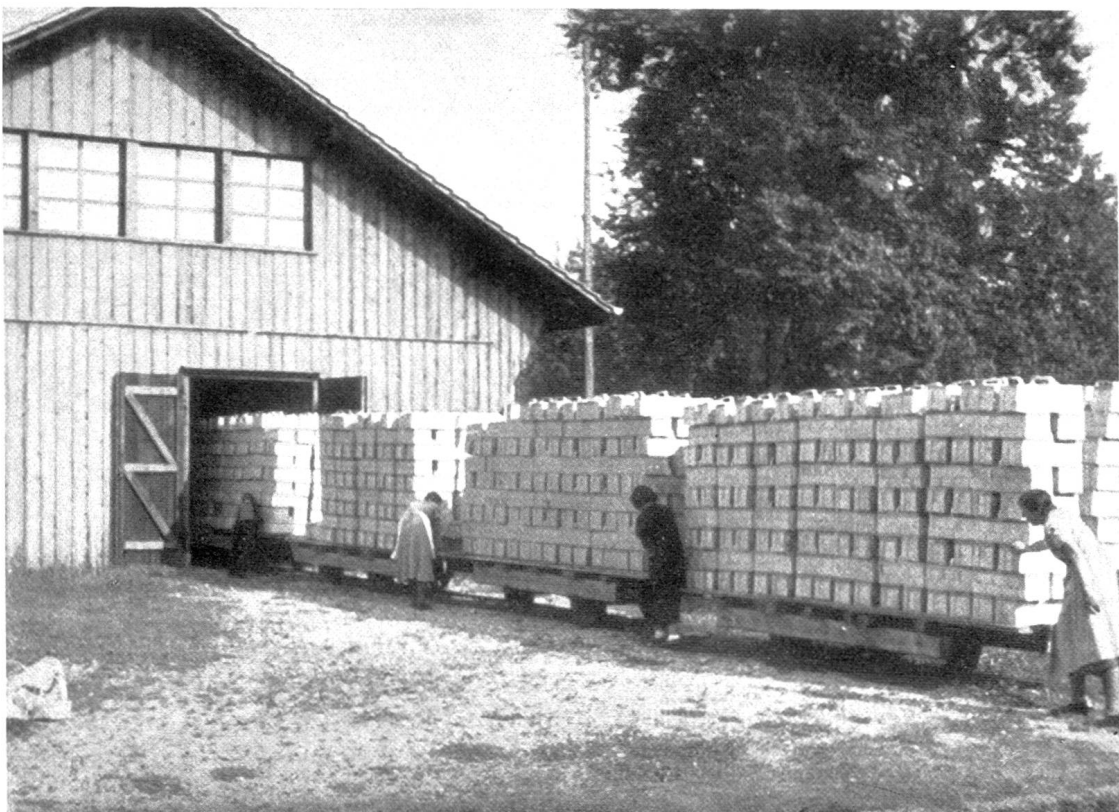
Abb. 4. Die fertigen Körbe werden auf Rollwagen geladen, an der Luft getrocknet und nachher in den Lagerschuppen gebracht.
