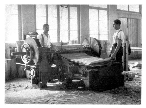
Abb. 1. Der Stamm wird geschält. Vorderansicht der Maschine.
