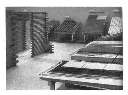
Abb. 3. Baubedarf und Bauelemente: Schrägdächer mit Ziegeln und Eternit, verschiedene Flachdächer.
