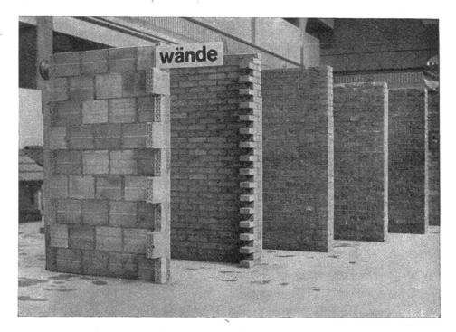
Abb. 2. Baubedarf und Hauselemente: Gemauerte Wände.
