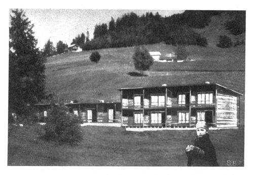
Abb. 8. Ferien-Appartementhaus (2 × 4) plus 6 Einheiten kombiniert. Entwurf Architekt BSA Ernst F. Burckhardt. Ausgeführt durch die Chaletfabrik Bündner Oberland, Ilanz, in Holzblockbau nach eigenem patentierten System.
