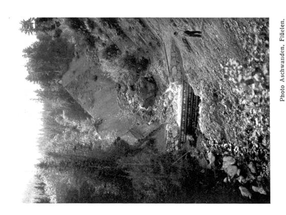
Abb. 4. Vorderbach-Gruonbach, Flüelen, Kastenwerksperre mit Steinflügeln (1914). Die Rutschflächen sind heute durch Berasung und Erlenpflanzung begrünt. Siehe Fig. 5, oberer Bildviertel rechts.
