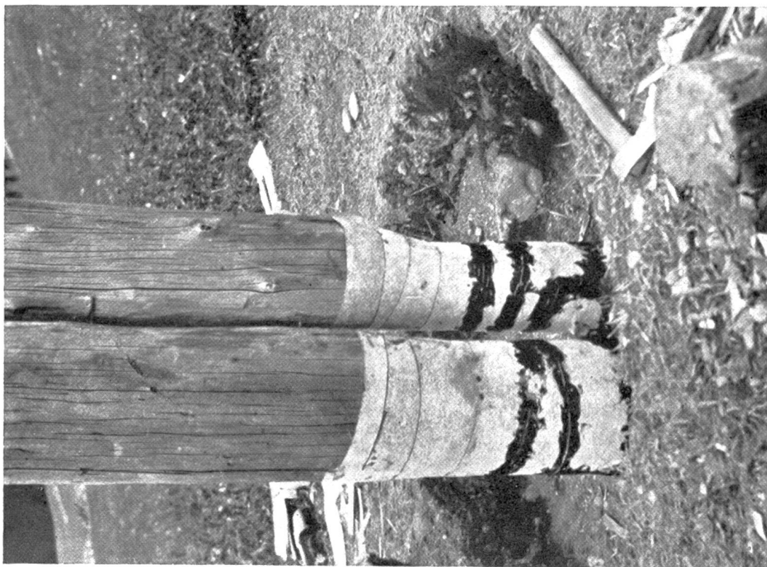
Abb. 2. Bandagierung verbauter Maste.
