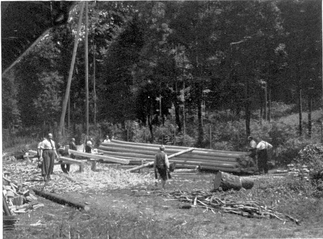
Abb. 1. Der Aufbau eines Mastenstapels für die Osmotierung. Die Maste werden auf den Böcken im Vordergrund geschält, mit der Imprägnierpaste bestrichen und hernach auf den Stapel gerollt.
