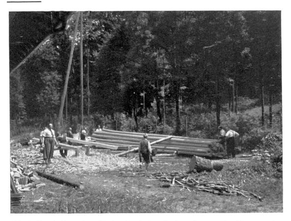
Abb. 1. Der Aufbau eines Mastenstapels für die Osmotierung. Die Maste werden auf den Böcken im Vordergrund geschält, mit der Imprägnierpaste bestrichen und hernach auf den Stapel gerollt.
