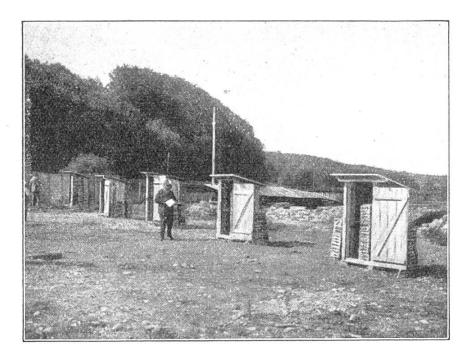
Abb. 3. Die geöffneten Versuchshäuschen mit Holzverteilung.
