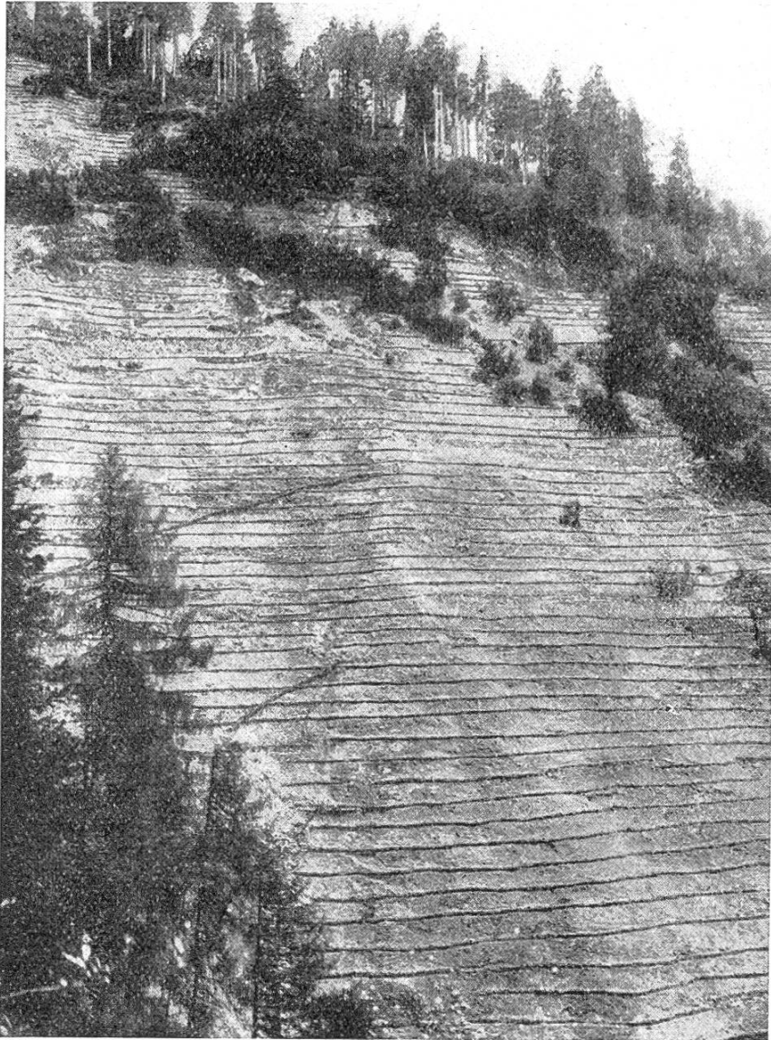
Abb. 8. Die Rutschfläche „Lavinal“ im Pontaibagebiet nach der ersten Phase der Arbeiten (1927).
