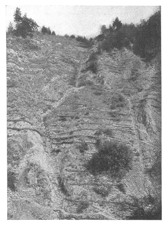
Abb. 7. Befestigung, Berasung und teilweise Aufforstung. Der Hang ist bereits vollständig stabilisiert.
