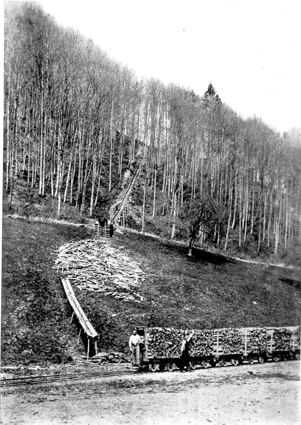
Abb. 1. Holztransport im Sihlwald ca. 1890, beim Försterhaus Sihlbrugg. Durch die hintere lange Holzriese wird das weiter oben durch fliegende Geleise und Schlittwege gesammelte Holz über den Steilhang transportiert. Die kleine kurze Riese bringt das Holz zu der auf der Talsohle liegenden permanenten Waldbahn, welche längs der Sihl nach dem Werkplatz Sihlwald führt.
