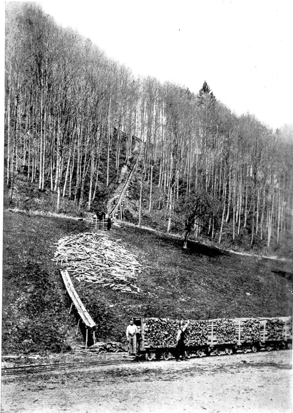
Abb. 1. Holztransport im Sihlwald ca. 1890, beim Försterhaus Sihlbrugg. Durch die hintere lange Holzriesen wird das weiter oben durch fliegende Geleise und Schlittwege gesammelte Holz über den Steilhang transportiert. Die kleine kurze Riesen bringt das Holz zu der auf der Talsohle liegenden permanenten Waldbahn, welche längs der Sihl nach dem Werkplatz Sihlwald führt.
