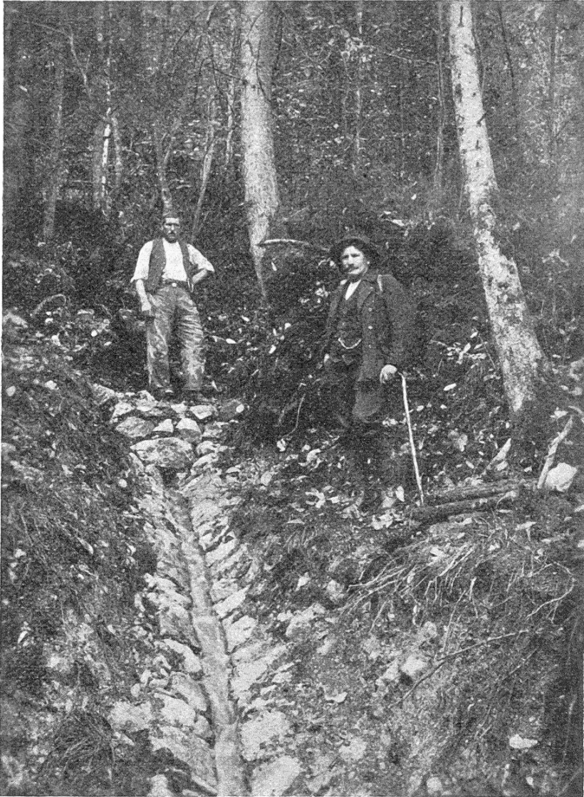
Abb. 6 a. Quellfassung und Ableitung mittelst eines offenen Grabens an Stelle einer ursprünglichen Sickerdole.
