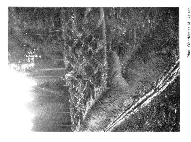
Abb. 4. Hauptabilussgraben mit eingebauter Rinne aus Holzplatten, zwecks Sicherung der Grabensohle.
