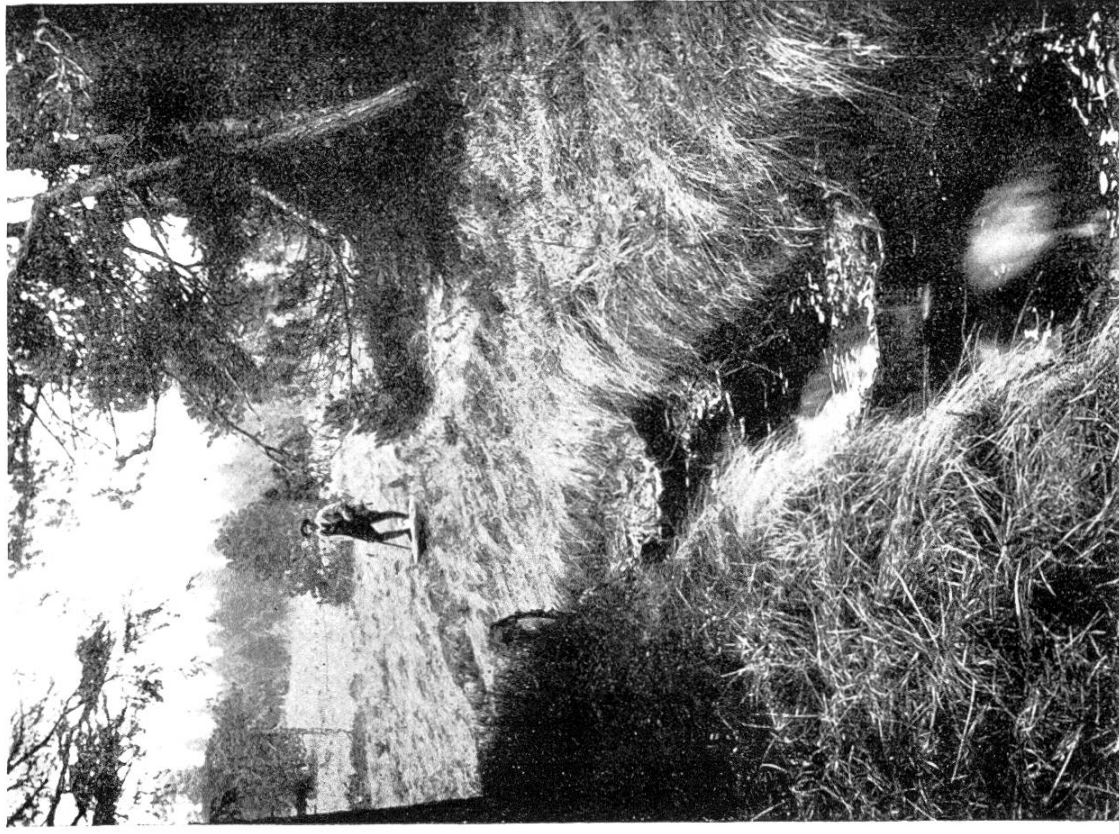
Abb. 1 c. Die früher vielfach angewendete Pfahlreihenverbauung als Sohlensicherung, führte im Laufe der Zeit zu Wasserstauungen, die Rutschungen in den tieferen Lagen verursachen. Das System hat sich als unzweckmässig erwiesen.
