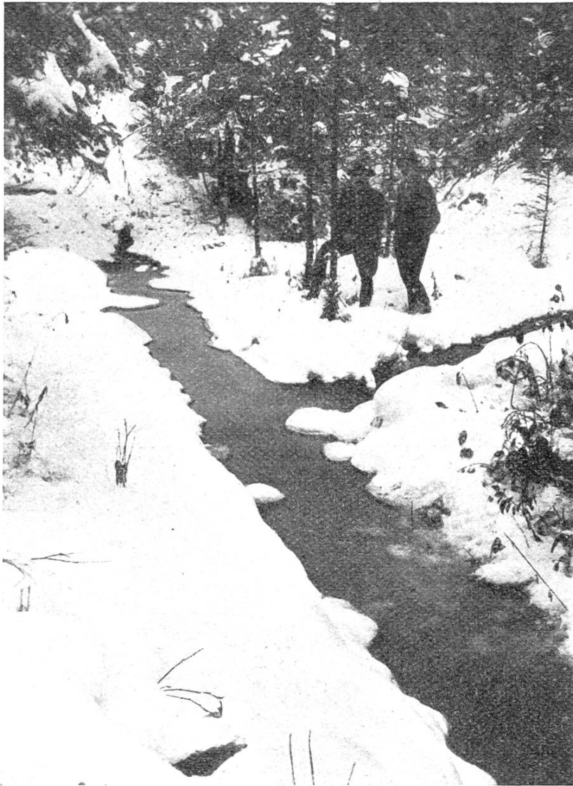
Abb. 1a. Zuzolge ungenügender Gefälle und nachträglicher Senkung des Bodens sind die Seitengräben (Nebenrinnen) nicht mehr imstande, sich zu entleeren.
