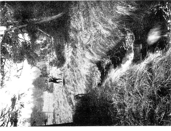
Abb. 1 c. Die früher vielfach angewendete Pfahlreihenverbauung als Sohlensicherung, führte im Laufe der Zeit zu Wasserstauungen, die Rutschungen in den tieferen Lagen verursachen. Das System hat sich als unzweckmässig erwiesen.
