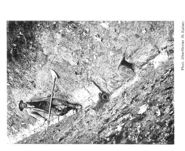
Abb. 3. Hauptabflussgraben mit eingebauter Steinschale als Sohlensicherung. Daneben Ueberlaufquellen, die zur Zeit der Schneeschmelze eine bedeutende Wassermenge führen.
