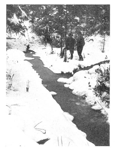
Abb. 1a. Zufolge ungenügender Gefälle und nachträglicher Senkung des Bodens sind die Seitengräben (Nebengräben) nicht mehr imstande, sich zu entleeren.
