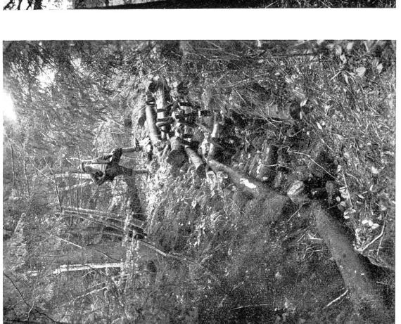
Abb. 1 b. Sohlensicherung, bestehend aus Steinpackung und Astwerkmaterial nebst Leitwerken, Querschwellen aus Holz, nach kurzer Zeit in schlechtem Zustande!
