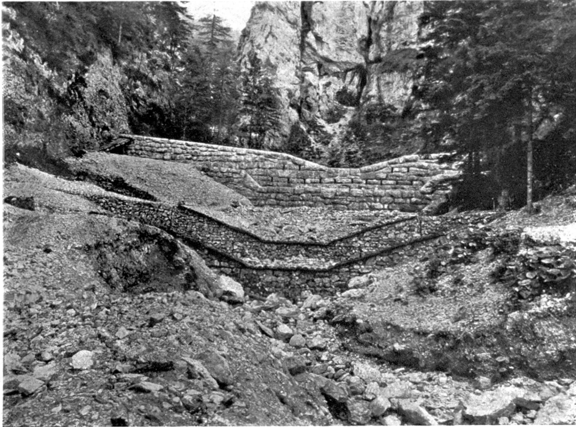
Abb. 1. Vorsperren aus Drahtschotterbehältern mit Holzbedielung im Hagenbach, Nieder-Oesterreich.
