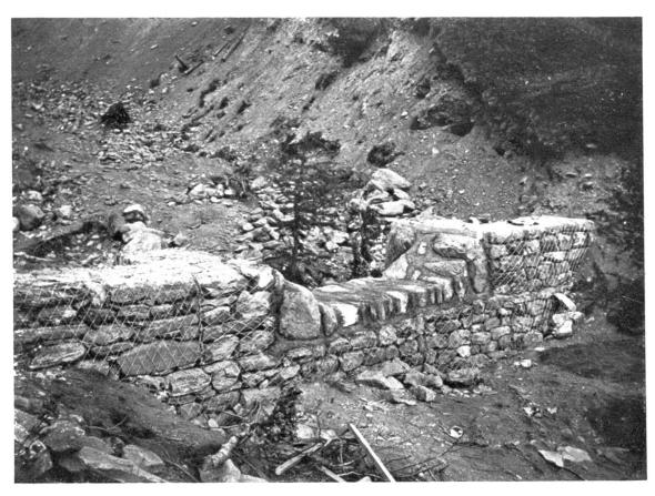
Abb. 4. Gitterkastensperre bei Olivone. Phot. Müller, 1930. Die Abstußsettion ist durch einen in Mörtel gelegten Steinsatz geschützt (gleiches Objett wie Abb. 3).
