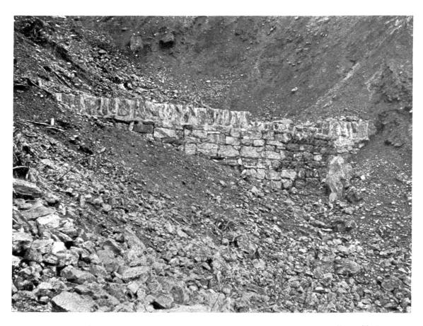
Abb. 2. Sitterkastensperre bei Olivone. Phot. Müller 1930. Dasselbe Objett wie auf der Stizze. Es sind nur die zweite und dritte Lage der Sitterkasten (zusammen 2 m hoch) und die Krone in Steinsatz sichtbar.
