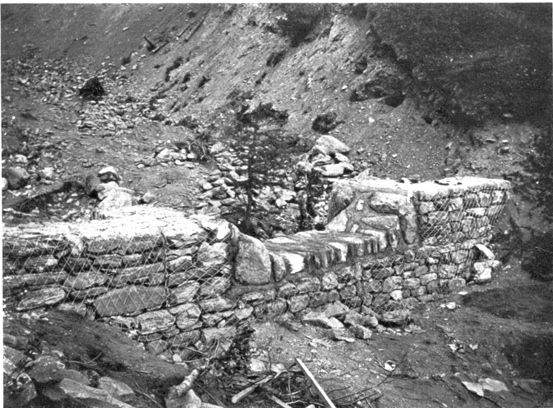
Abb. 4. Gitterkastensperre bei Olivone. Phot. Müller, 1930.
