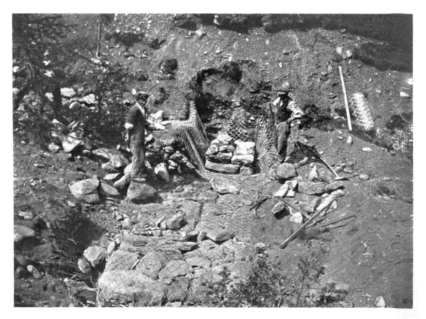
Abb 3. Bau einer Gitterkastensperre bei Olivone. Phot. Müller, 1930. Die erste Lage der Gitterkasten ist ausgeführt und befindet sich gänzlich im Boden, die zweite Lage uft in Ausführung begriffen.
