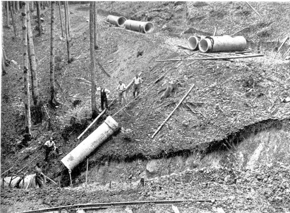
Abb. 2. Verlegen von Vianiniröhren.
