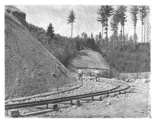
T. P. 2: Abschnitt bei Kiesgrube im Bau Phot. Krebs Legen bes Steinbettes 20 cm ftark mit Material aus Brunnen. — Einschnittsböschungen 1:1. In ber hinteren Böschung Pfahlreihen mit Steinhinterbeugung längs Quellhorizont
