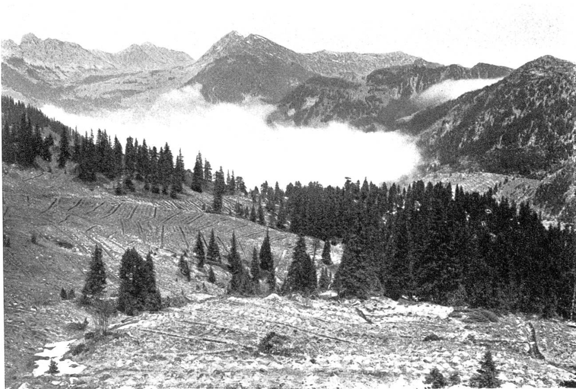
Abb. 3. Entwässerungssystem mit offenen Gräben und Verhügelung des Aushubmaterials
