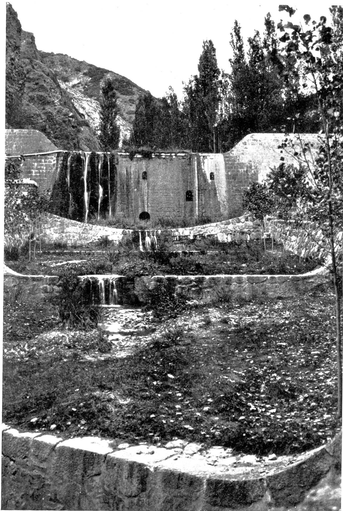
Abb. 5. Der Enseubach im Noguera-Pallaresatal Eine der höchsten und größten Retentionsperren im mittleren Lauf, mit Vorseperren
