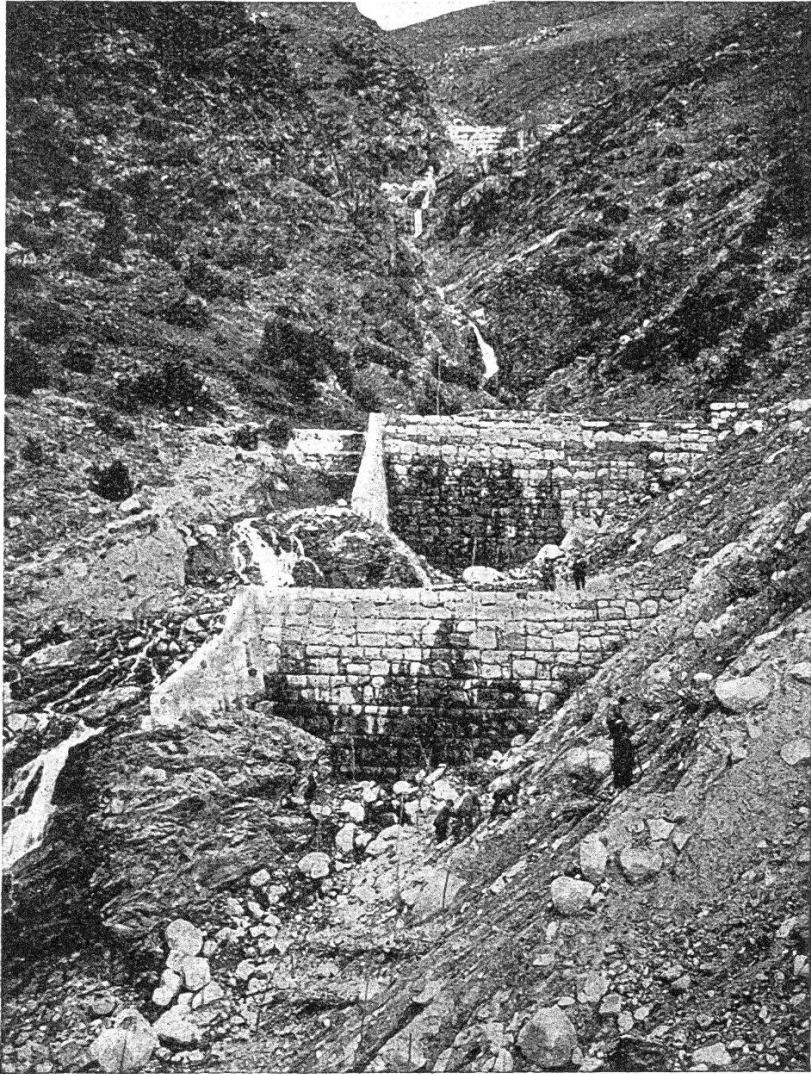
Abb. 4. Der Grinnolobach im Capdellatal (Mit Konsolidierungssperren und Ableitungswerken, -sperren und -kanal)
