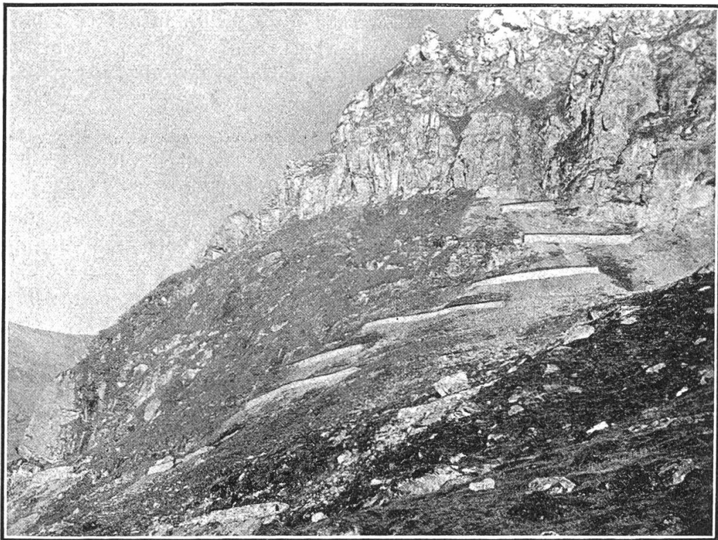
Abb. 4. Verbauung am Horn Bals; Fangmauern und Couloirabschlüsse
