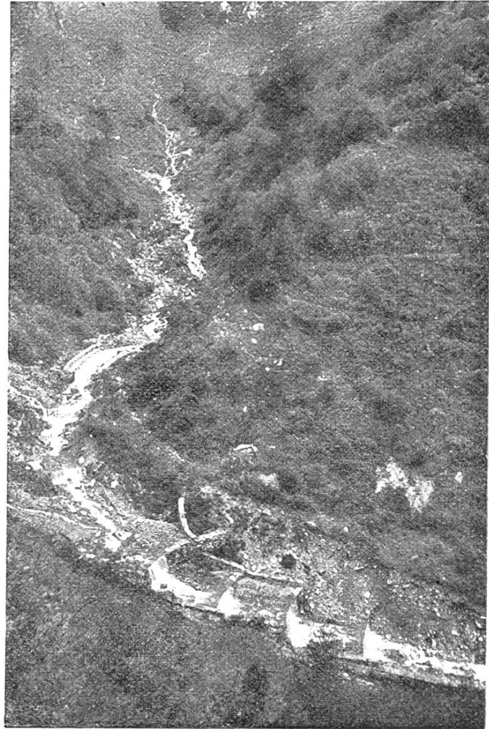
Abb. 3. Verbauungen im Cujellobach Aufnahme 1924
