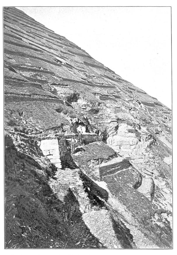
Cawinenverbau an der Meißenplanke bei Elm mittels gemischter Terrassen und einzelner Mauerterrassen
