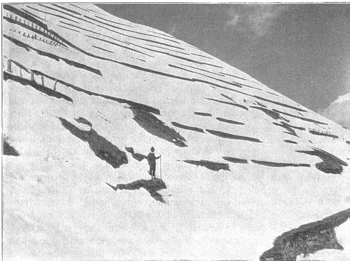
Fig. 5. Weissenplanke bei Elm. Mauerterrassen, gemischte Terrassen und schmälere Terrassen mit Pfahlreihen bei stark zurückgegangener Schneedecke.
