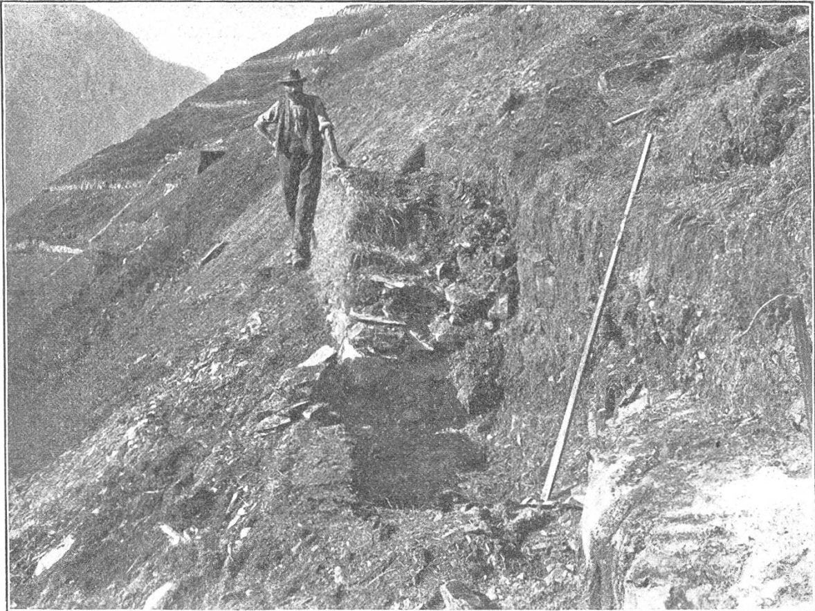
Fig. 2. Meißenplante bei Elm. Gemischte Terrasse im Bau.
