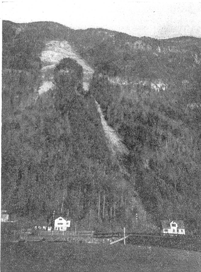
Felsabbruch im Bannwald zu Altdorf (Uri), 4. Januar 1920. (Links Brauerei Moosbad, rechts das Bettlerhaus.)
