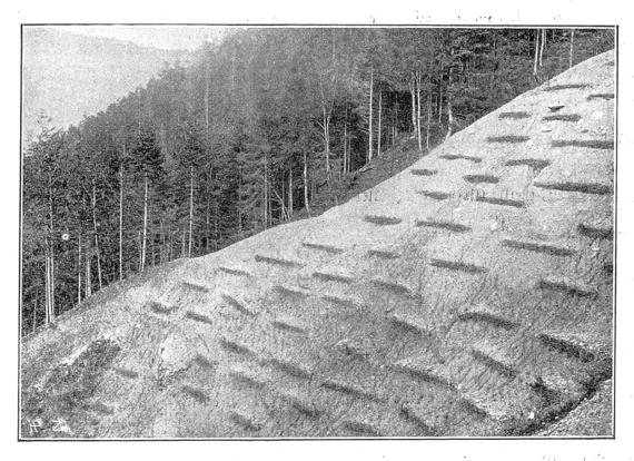
Rünftliche Ablöschung mit Flechtzäunen; Sperren vom Schutt zugedeckt.
