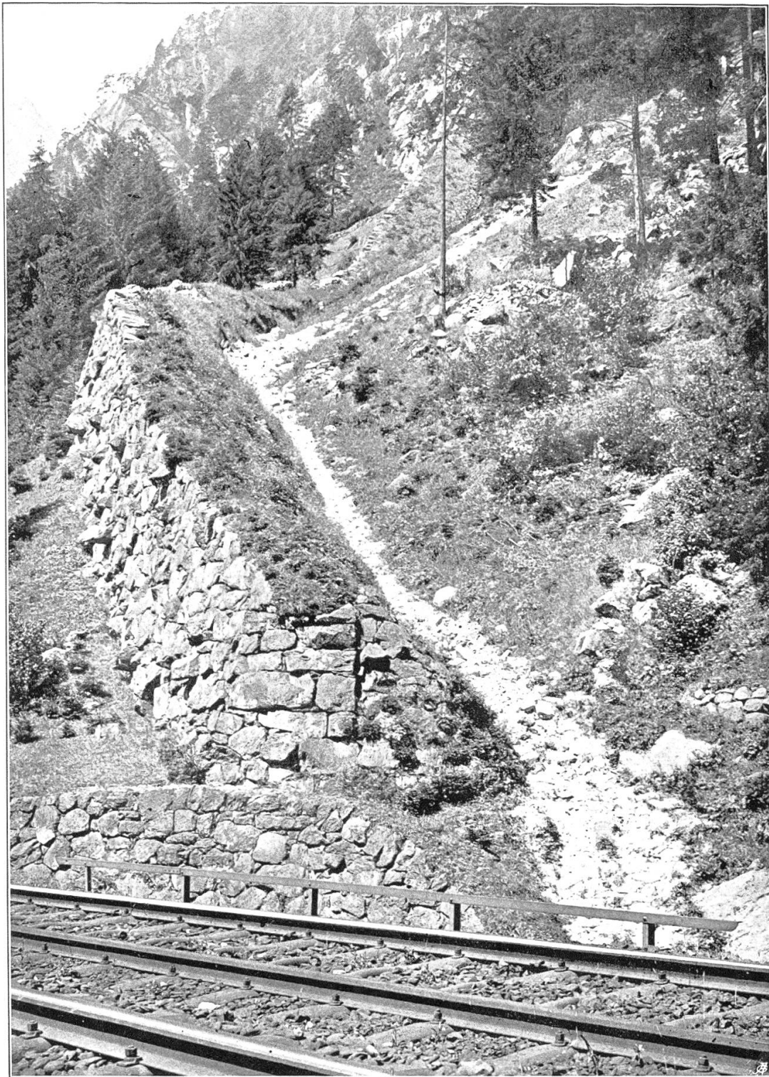
Leitdamm aus Trockenmauerwerk mit Erdschüttung für den Keilzug „Auf der Höhe“ an der Gotthardbahn zwischen Gurtellen und Wassen.
