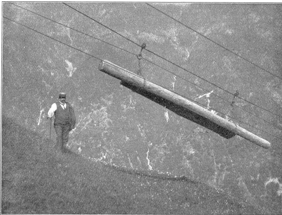
Fig. 3. Drahtseilrieße der Gemeinde Mesocco. — Transport von Langholz.
