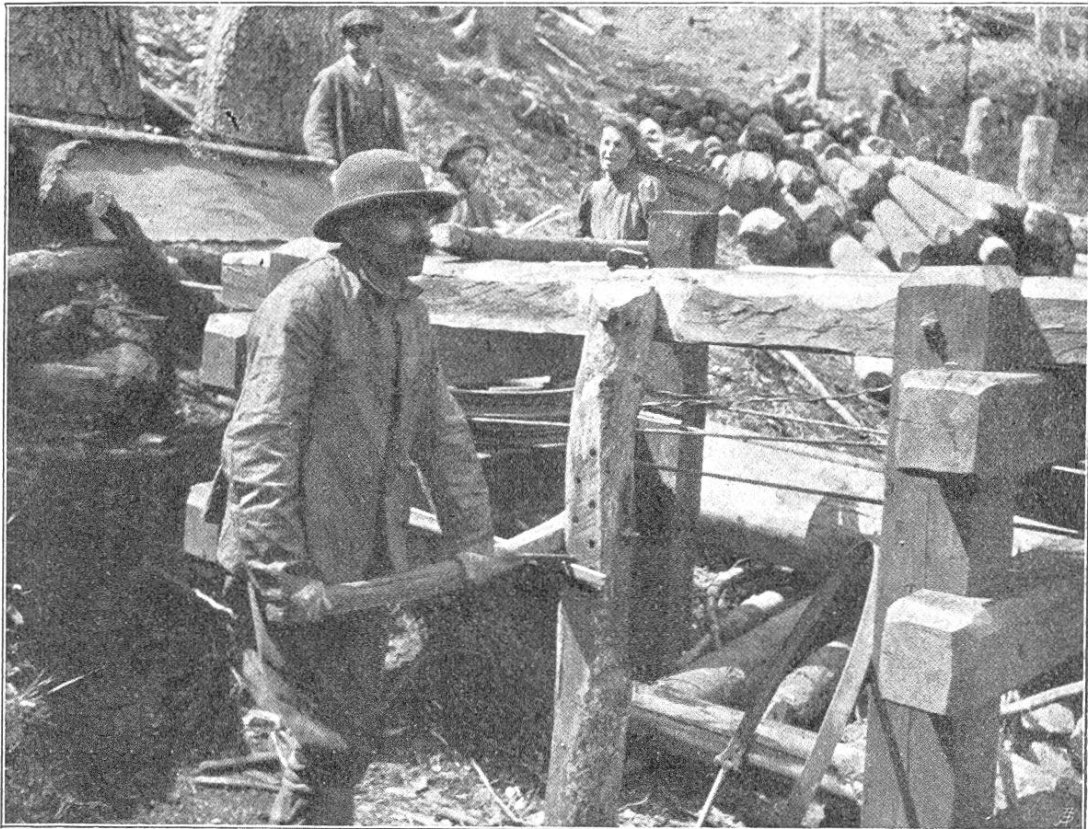
Fig. 1. Drahtseilriege der Gemeinde Mesocco. — Bremsvorrichtung.
