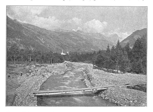
Fig. 1. Wiederherstellung der Uferversicherungen am Schächenbach oberhalb der Brücke bei Schattdorf.
