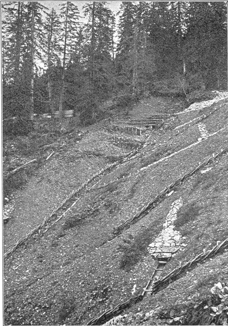
Fig. 4. Einzugsgebiet des Lungerer Dorfbaches: Konsolidierung einer Anbruchfläche durch Entwässerung.
