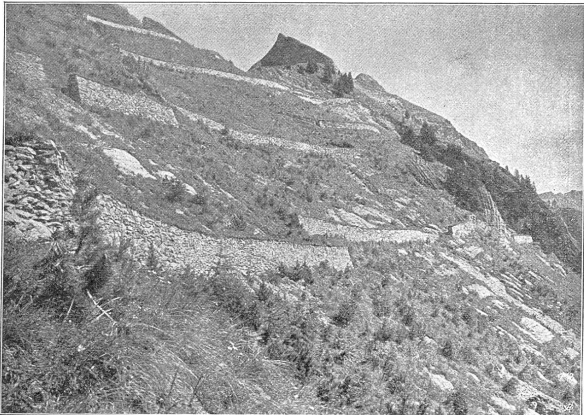
Fig. 2. Einzugsgebiet des Trachtbaches bei Brienz: Lawinenverbau und Aufforstung in der Obern Urseren.
