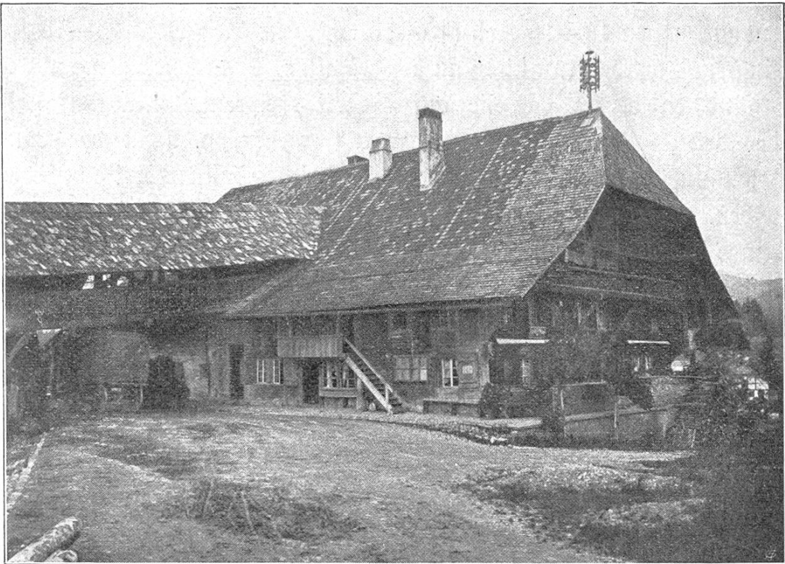
Fig. 1. Mit Federschindeln, zunächst den Kaminen mit Dachziegeln gedecktes Haus auf der Schwarzenegg bei Thun.
