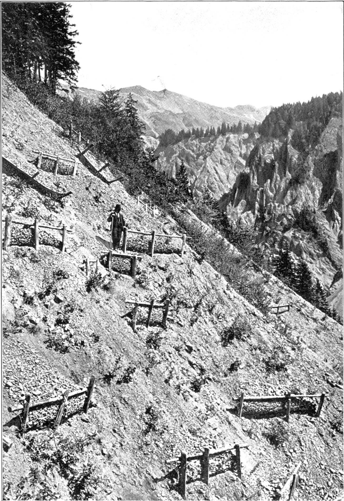
Drahttetter zur Befestigung einer Geröllhalde im Lammbach-Tobel, bei Brienz.
