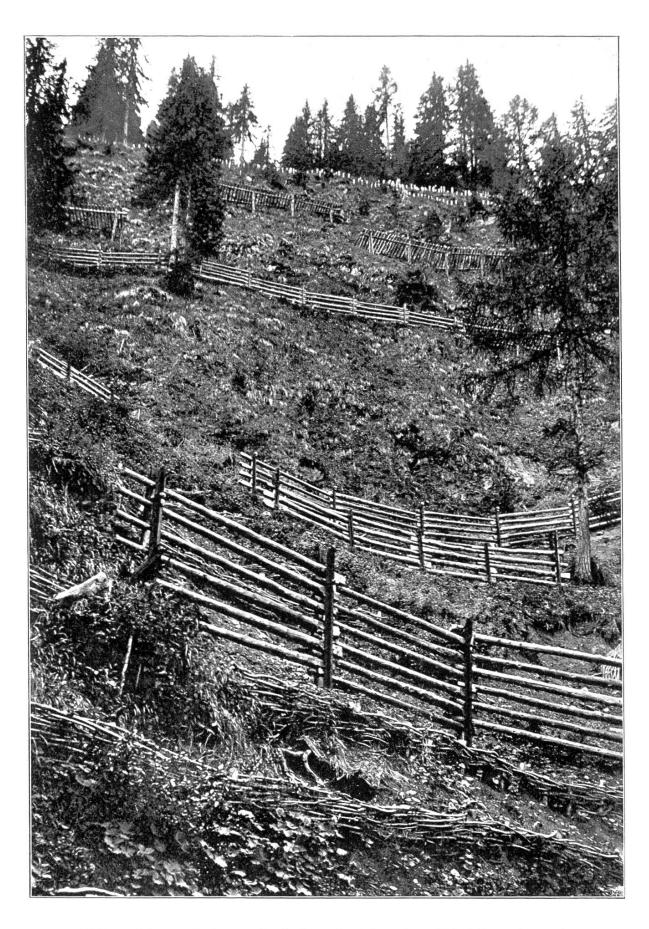
Schneeschutzwände und Schneebrücken im südlichen Zug der Calcestri=Tawine bei Piotta, Km 91,100/300.
