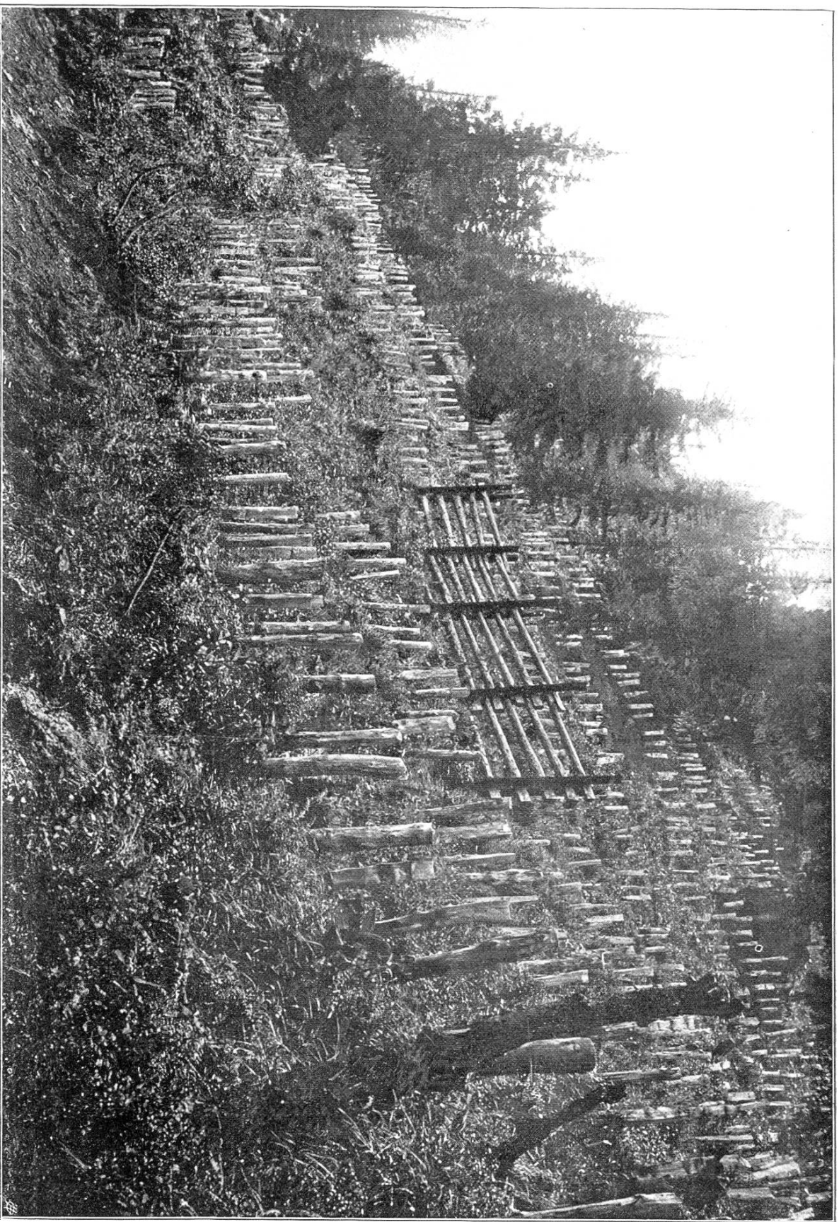
Verpfählung und Schneefuchswand im nördlichen oberen Teil der Salceftri-Laraine bei Piotta.
