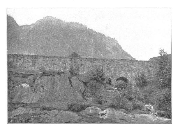
Fig. 5. Schutzmauer gegen die Entschigtallawine an der untern Bahnlinie bei Wassen, km 60,150—60,200.
