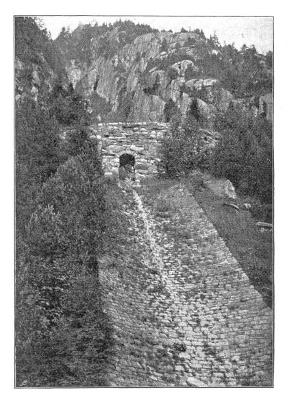
Fig. 2. Lawinensperrmauer in der Ribistöcklikehle untershalb Göschenen, km 69,760.
