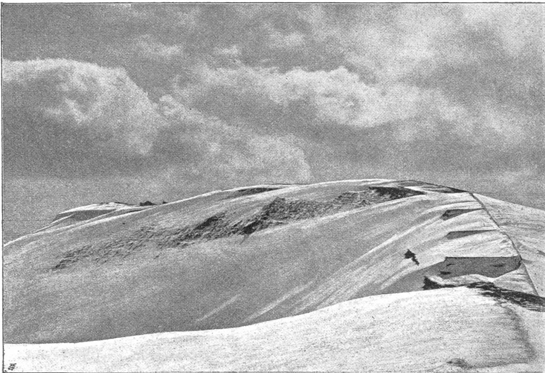
Fig. 6. Schneeablagerung vor und hinter dem Lawinen-Schutzdamm.
