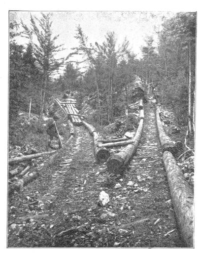
Fig 4. Bereinigung zweier Stränge des Mittenbrachberg-Riesweges, bei Ischl, im linkseitigen mit eingehängtem "Wolf".
