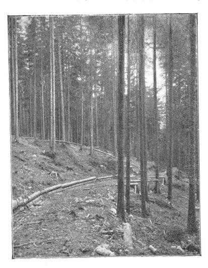
Fig. 3. Ausgleich einer zu engen Kurve durch Verbreiterung des Riesweges in Schwabeleckwald, bei Gisenerz.
