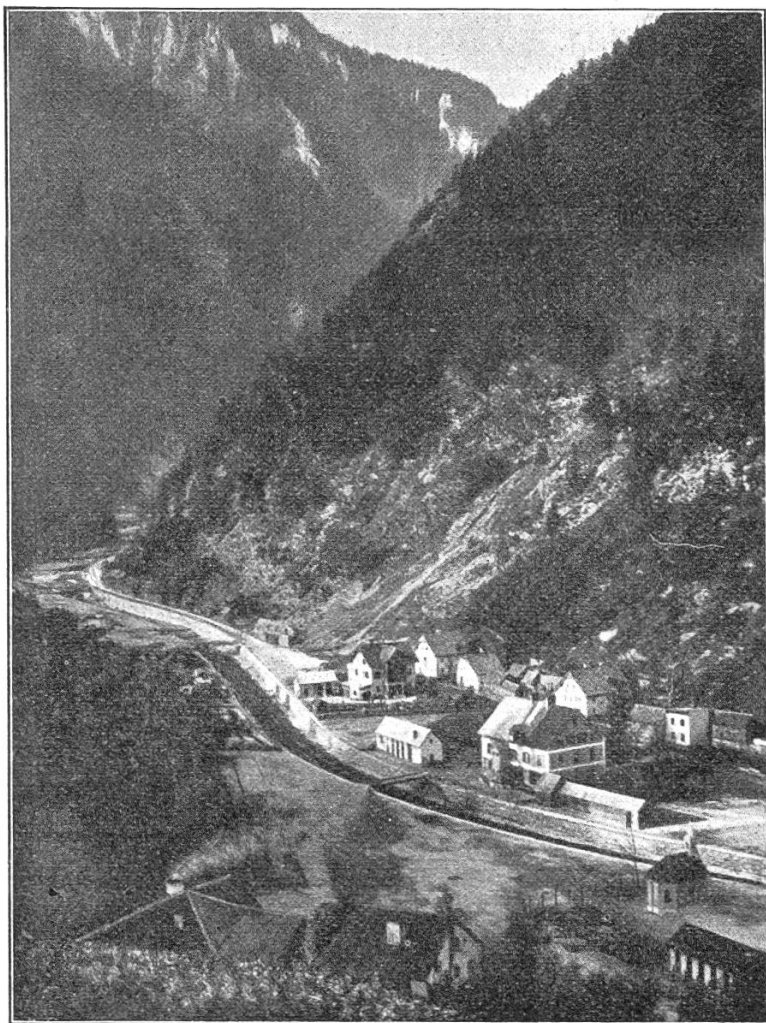
Fig. 4. Regulierung des Langbathbaches in seinem untern Lauf.
