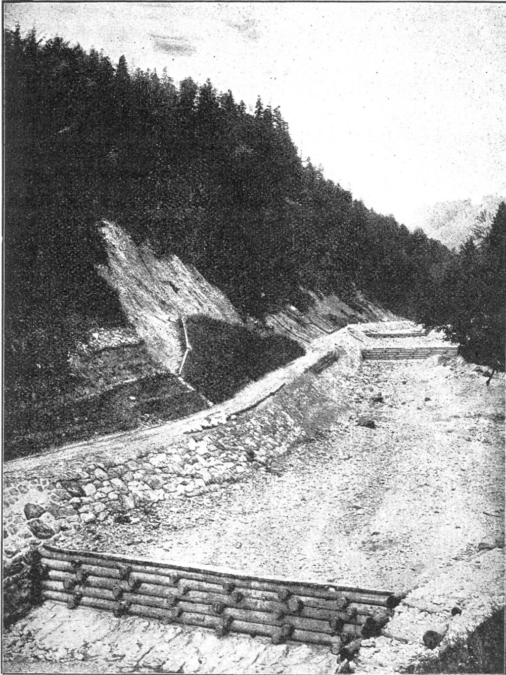
Fig. 2. Lehnsicherung durch Spreitlagendamm.
