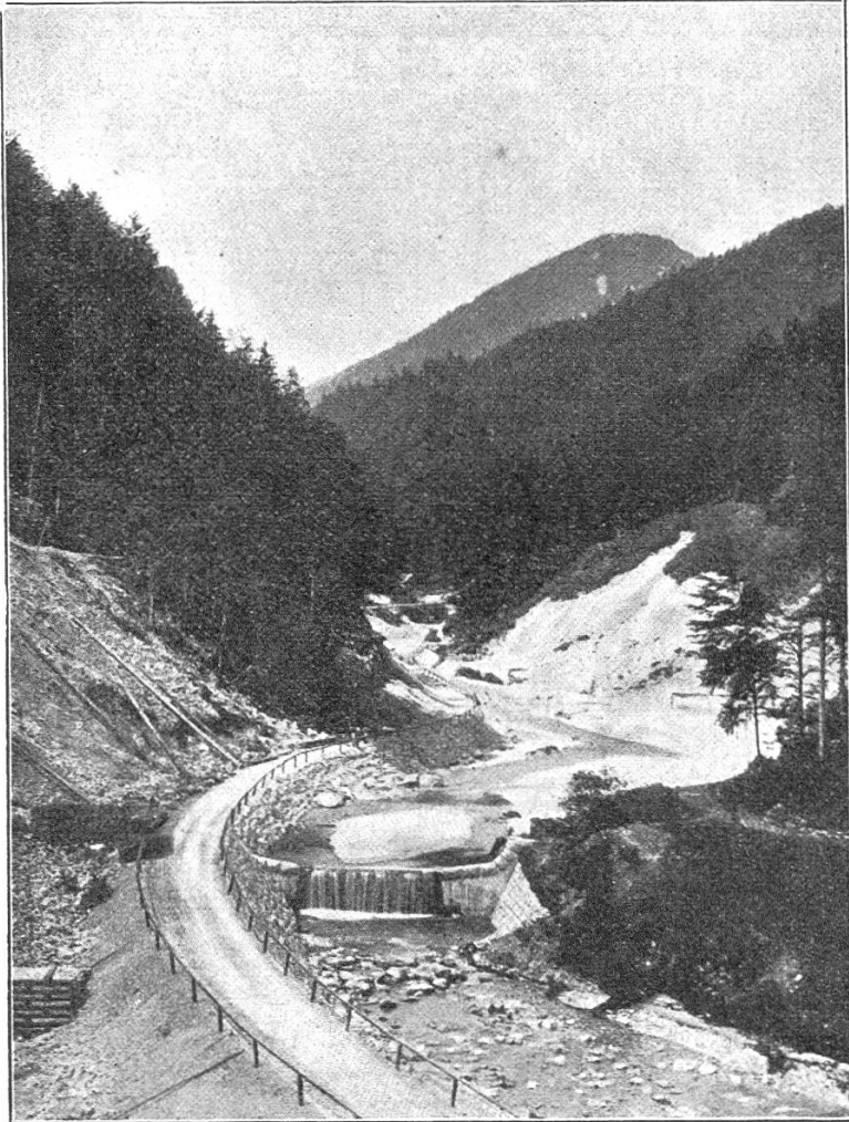
Fig. 1. Verbauung am mittleren Laufe des Langbathbaches.
