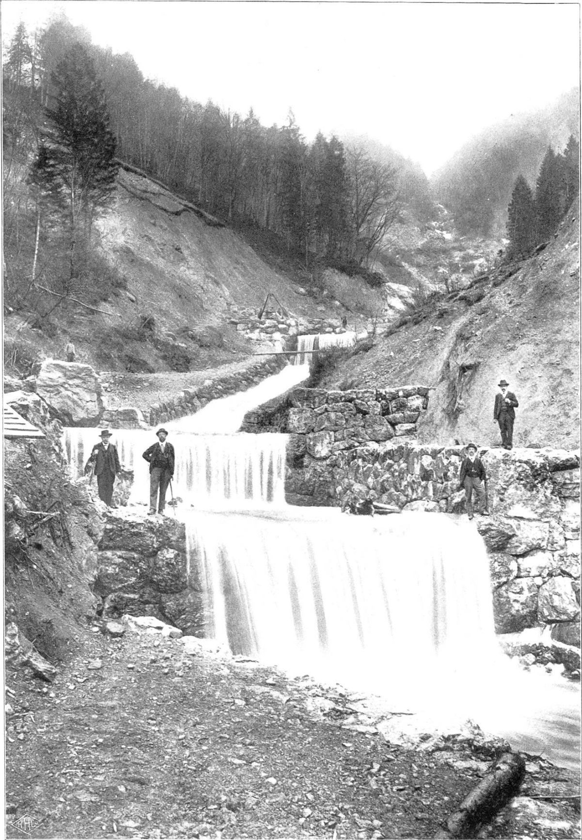
Partie aus der Verbauung des Flybaches bei Weesen.
