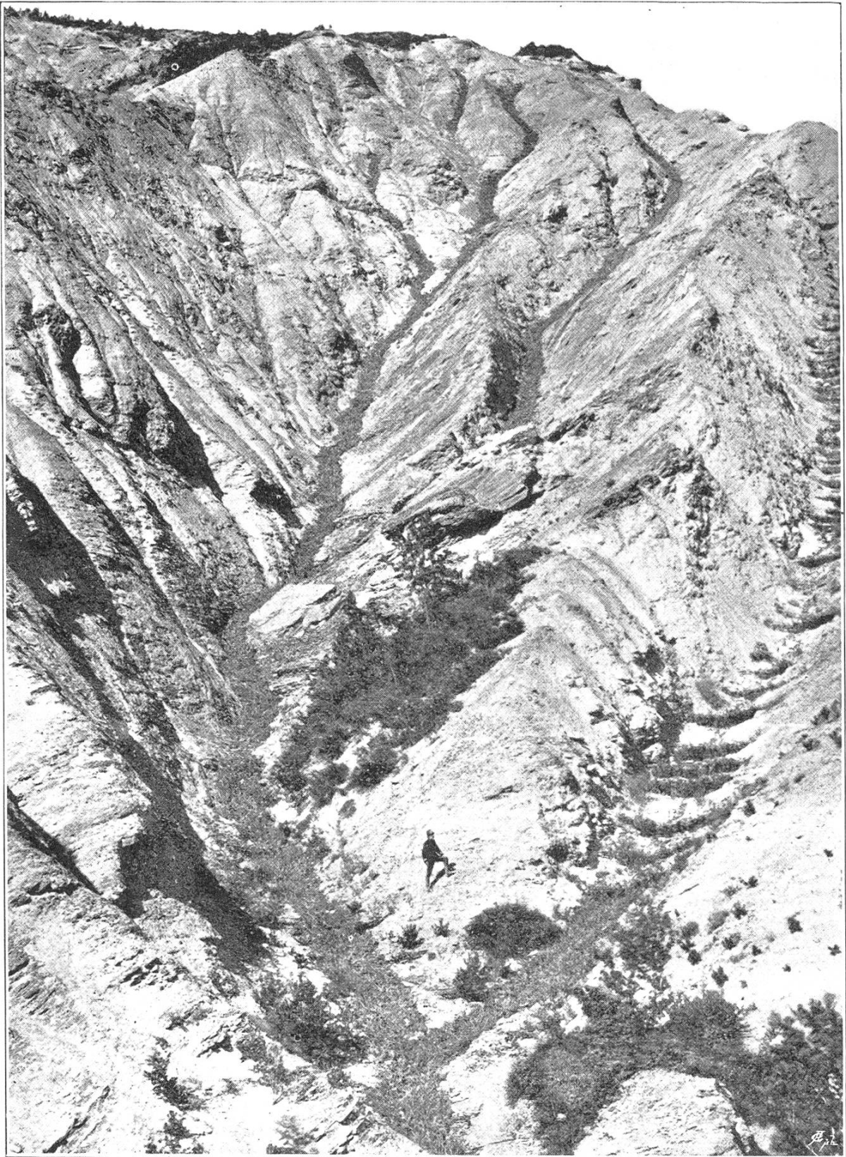
Verkleidungen in der Combe von Villevieille. La Combe de Villevieille consolidée par le garnissage.
