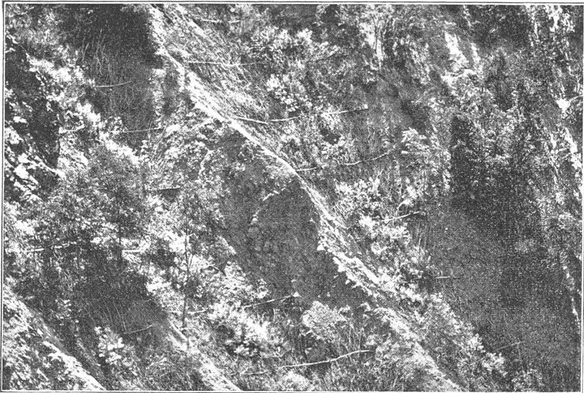
Verkleidung von Runsen im Labouret. Ravins du Labouret traités par le garnissage.
